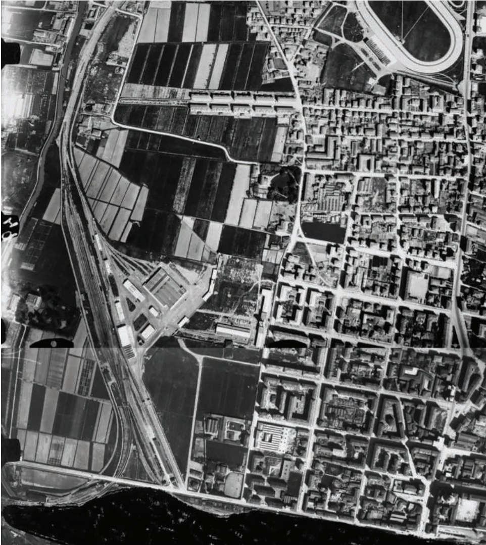
FIGURE 11.3 Aerial view of the market area in 1937, Comune di Bologna/Istituto geografico militare italiano.
