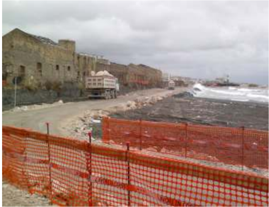
Fig. 11. Marina di Vigliena, Porto Fiorito. A sinistra visibili i ruderi della vecchia fabbrica Corradini.
