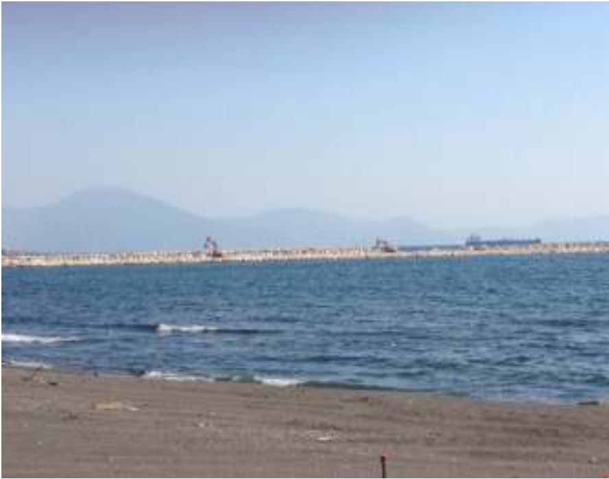
Fig. 12. Marina di Vigliena, Porto Fiorito. Realizzazione di un porto turistico e relative infrastrutture a terra (2012).
